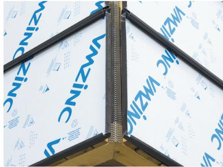
**2.** Die Scharen werden so verlegt, dass ein 35mm breiter Luftraum im Firstbereich bestehen bleibt. Dieser Bereich sollte mit einem Insektengitter (kein Systembestandteil) geschützt werden.
