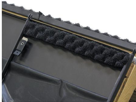
**5.** Kleben Sie den Dekompressionsstreifen zwischen die Stehfalze. Der Streifen sollte 10mm unter der Aufkantung liegen und die Länge des Streifens sollte 20 mm breiter sein als der Abstand zwischen den Stehfalzen.
