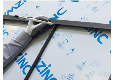
**3.** Legen Sie eine G3-Firstabdeckung auf die Falze und markieren Sie deren Position auf den Falzen. Entfernen Sie nun die Folie im markierten Bereich.
