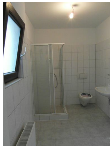
ETW EG Hinten Dusche/Badezimmer mit Tageslicht
