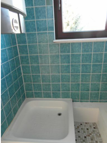
ETW OG Links Badezimmer/Dusche mit Tageslicht
