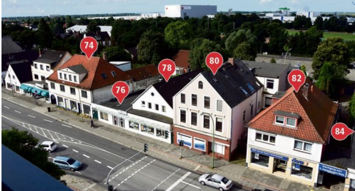
Die Gebäude mit den Hausnummern 74, 76, 78, 80, 82 und 84 (nicht im Bild) sollen abgerissen werden. Geben soll es von der Weserstraße künftig eine neue Straße zum Kappelmann-Platz. Sie soll dort verlaufen, wo heute noch das Haus mit der Nummer 74 steht. Foto Rabbel
