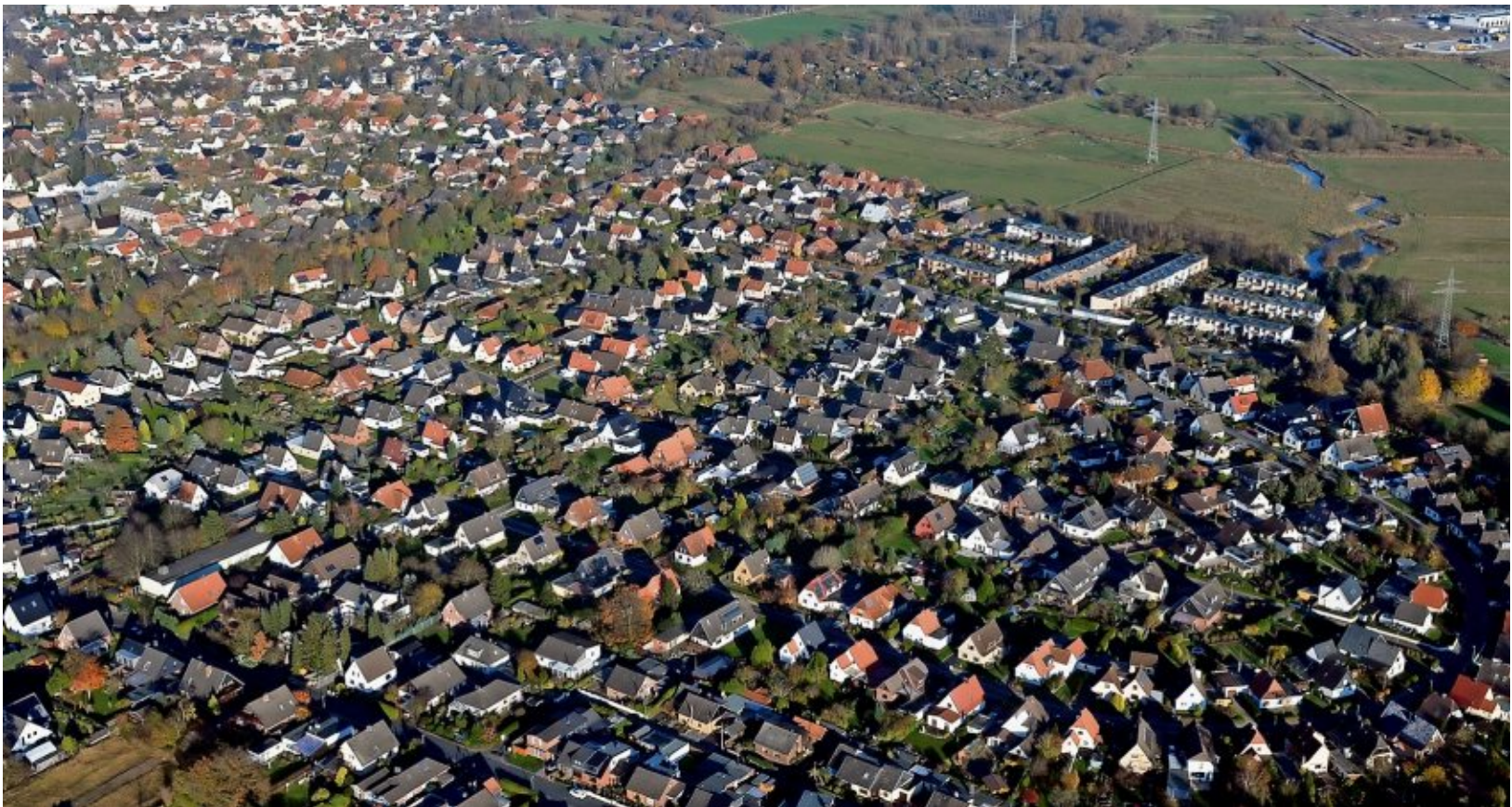
Die Industriesiedlung in Wulsdorf. Zurzeit stehen auf dem 25 Hektar großen Plangebiet 240 Häuser. Die Grundstücke sind zwischen 800 und 1000 Quadratmeter groß. An einigen Stellen könnten durch Grundstückszusammenlegungen knapp 100 neue Baugrundstücke entstehen. Archiv-Foto Scheer
