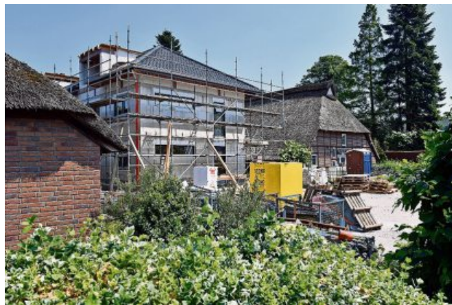
An der Allersstraße entsteht zurzeit ein neues Mehrfamilienhaus. Das alte Bauernhaus rechts daneben wird abgerissen.
