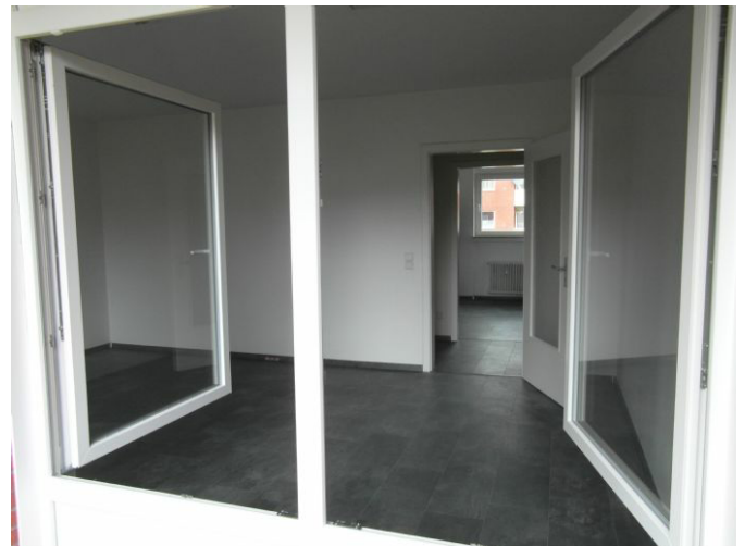
Balkon zum Wohnzimmer -nach Renovierung-
