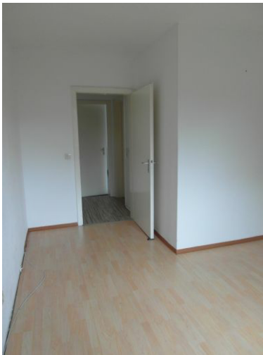
Schlafzimmer A -2- -vor Renovierung-
