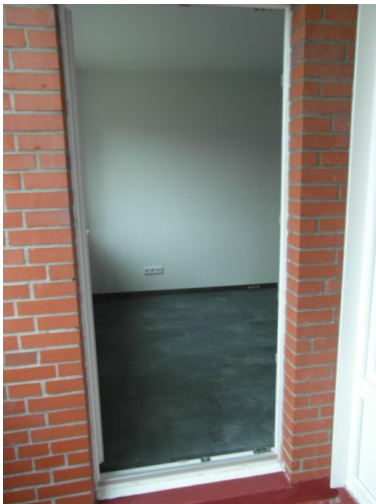
Balkon -nach Renovierung-
