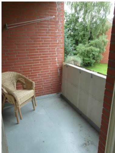
Balkon -vor Renovierung-
