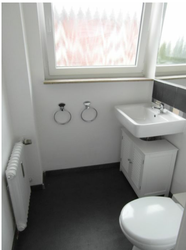
Gäste-WC -nach Renovierung-
