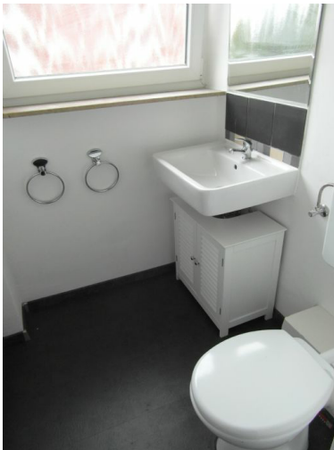
Gäste-WC -nach Renovierung-
