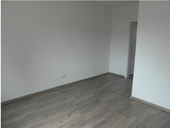
Schlafzimmer B-5--nach Renovierung-
