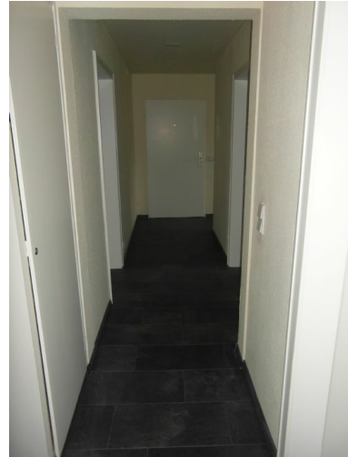
Flur Bad zum Eingang -nach Renovierung-
