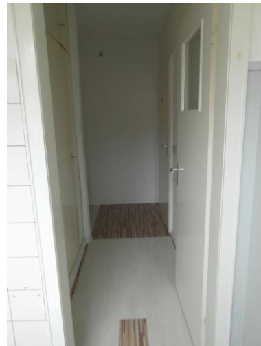
Gäste-WC ETW - Eingang -vor Renovierung-
