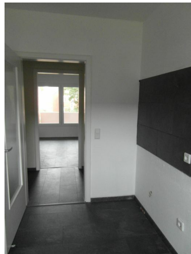
Küche -nach Renovierung-
