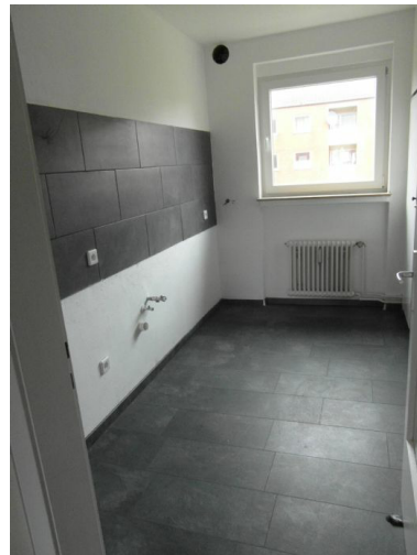
Küche -nach Renovierung-
