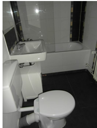
Badezimmer -nach Renovierung-
