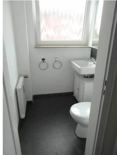
Gäste-WC -nach Renovierung-
