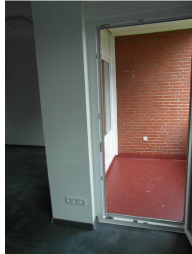
Balkon -nach Renovierung-
