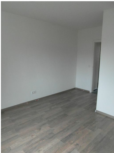
Schlafzimmer B-7--nach Renovierung-
