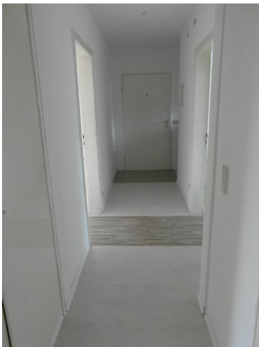
Bad Flur ETW Eingang -vor Renovierung-
