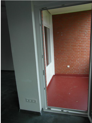
Balkon -nach Renovierung-
