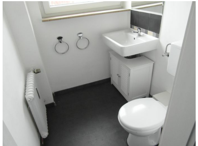
Gäste-WC -nach Renovierung-
