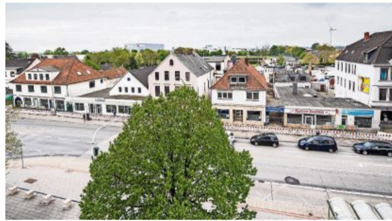
Ein Foto für das Geschichtsalbum: Wenn alles nach Plan verläuft, wird von den Häusern Weserstraße 74 bis 84 in sechs Wochen nichts mehr stehen.
