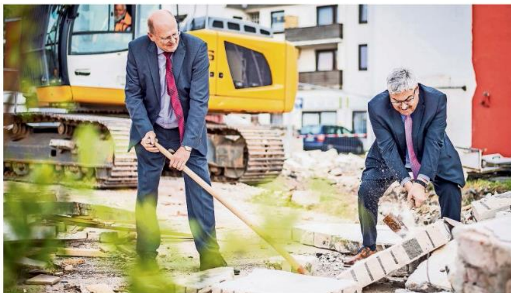
Symbolischer Start für die Abrissarbeiten in Wulsdorf: Oberbürgermeister Melf Grantz (rechts) lässt den Vorschlaghammer auf eine der bereits mit schwerem Gerät eingerissenen Wände krachen. Den ersten Schutt nimmt Dieckell-Geschäftsführer Dirk Grotheer auf die Schippe. Fotos: Hartmann
