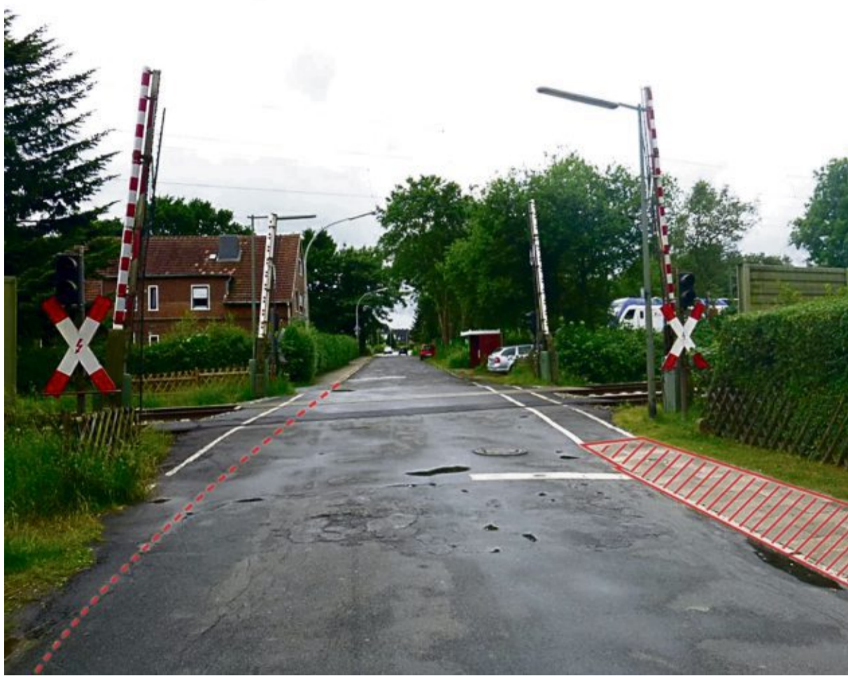
Der Bahnübergang Poggenbruchstraße soll erneuert werden. Im Zuge der Arbeiten wird der bisherige Gehweg von der Ecke Wikingerweg/Poggenbruchstraße bis zum Bahnübergang zurückgebaut und auf die andere Straßenseite (links im Bild) verlegt, damit Fußgänger nicht mehr die Straßenseite wechseln müssen. Foto: Claus/DB
