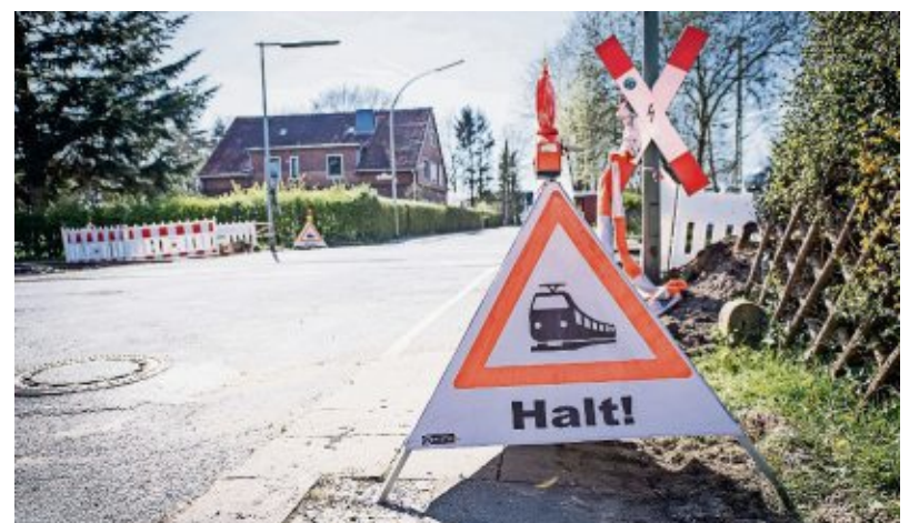
Ende März sind die Sanierungsarbeiten am Übergang Poggenbruchstraße angelaufen. Ab 20. April soll der Übergang für den Fahrzeugverkehr gesperrt werden. Fußgänger und Radfahrer können passieren. Foto: Hartmann
