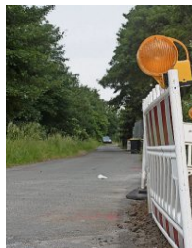
Im ersten Bauabschnitt werden Arbeiten an Abwasserkanälen vorgenommen. Foto: privat
