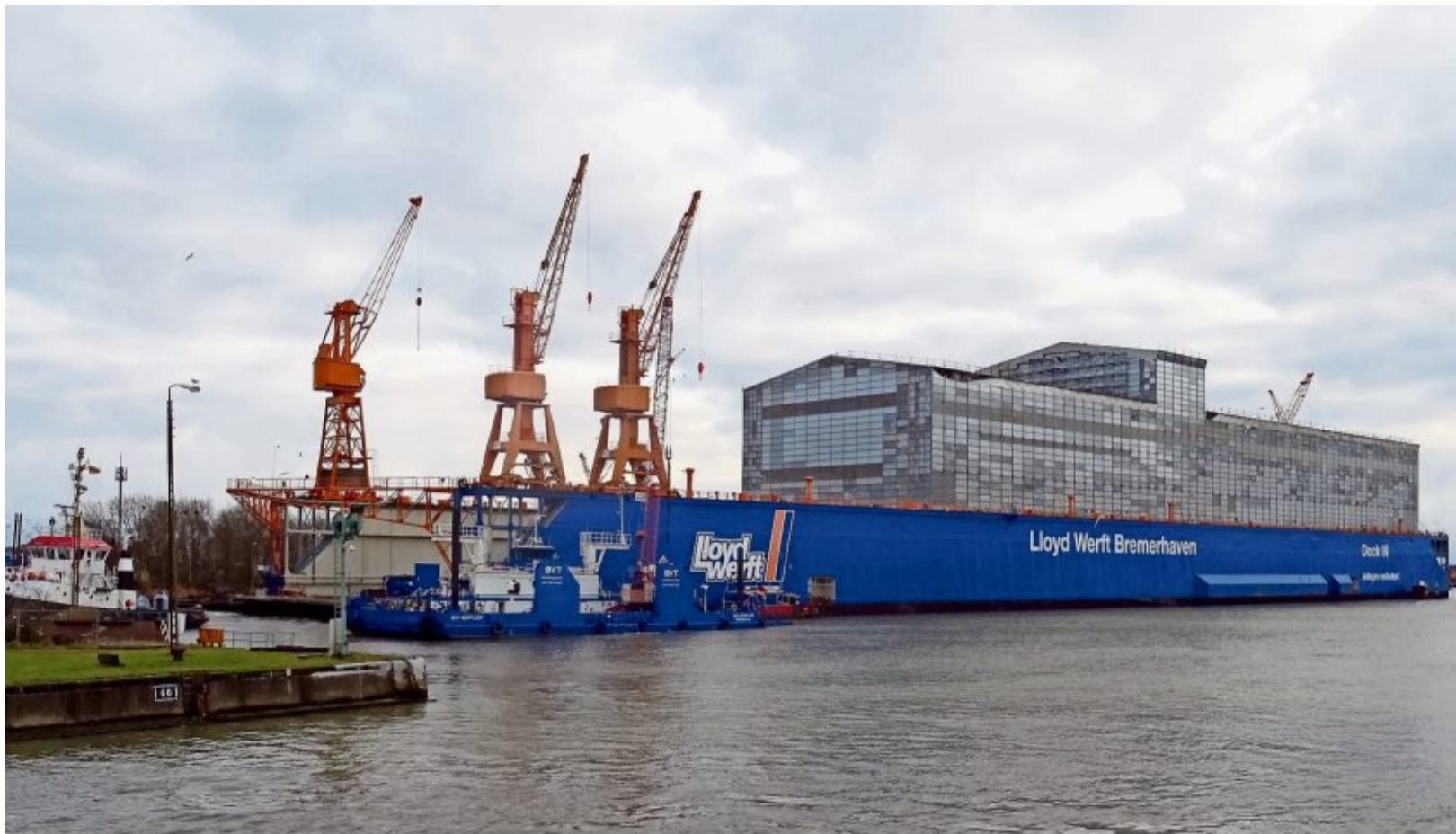
Wieder am Platz. Die Einrüstung des Schwimmdocks soll nach bald drei Jahren wieder abgebaut werden.
