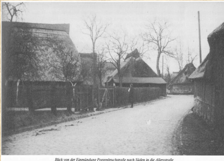
Blick von der Einmündung Poggenbruchstraße nach Süden in die Allersstraße
