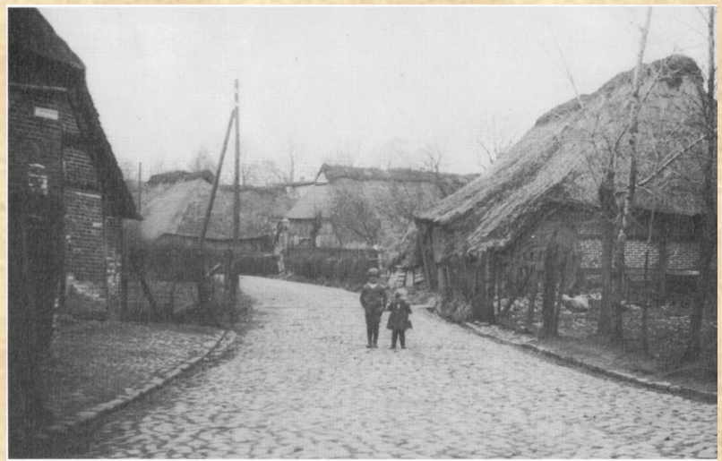
Blick von der Einmündung Poggenbruchstraße nach Norden in die Allersstraße
