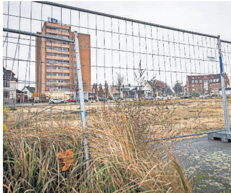
Blick auf die geräumte Brachfläche zwischen der Weserstraße und Heinrich-Kappellmann-Straße in Wulsdorf. Anfang kommenden Jahres soll Start für die Bebauung sein. Foto: Hartmann
