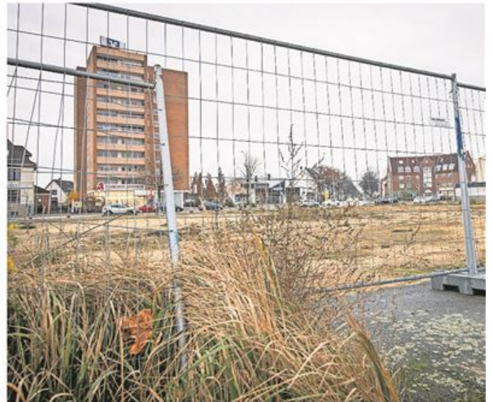
Blick auf die geräumte Brachfläche zwischen die Weserstraße und Heinrich-Kappelman-Strasse in Wulsdorf. Anfang kommenden Jahres soll Start für die Bebauung sein. Foto: Hartmann
