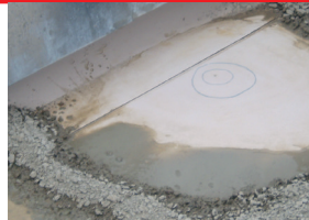
1 1. Leckstelle lokalisieren 2. QF dammartig aufschütten
