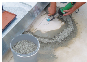
4 5. Nun kann die trockene Reparaturstelle bearbeitet werden
