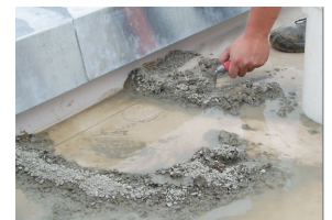
6 7. Entfernen des QF-Dammes und entsorgen über den Hausmüll
