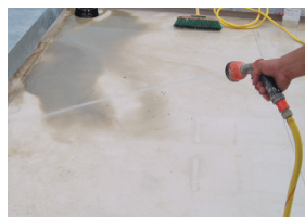
7 8. Abschlusarbeiten, Reinigen des Flachdaches
