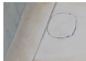
8 Die Flachdachreparatur ist abgeschlossen
