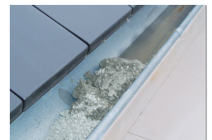
9 Abgrenzen des Wassers in einer vorhandenen Rinne, bei Reparaturarb.
