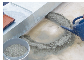
5 6. Dichtigkeitsprüfung der behandelten Reparaturstelle
