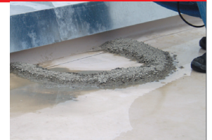
3 4. Durch den QF-Damm wird das nachfließende Wasser von der Reparaturstelle ferngehalten
